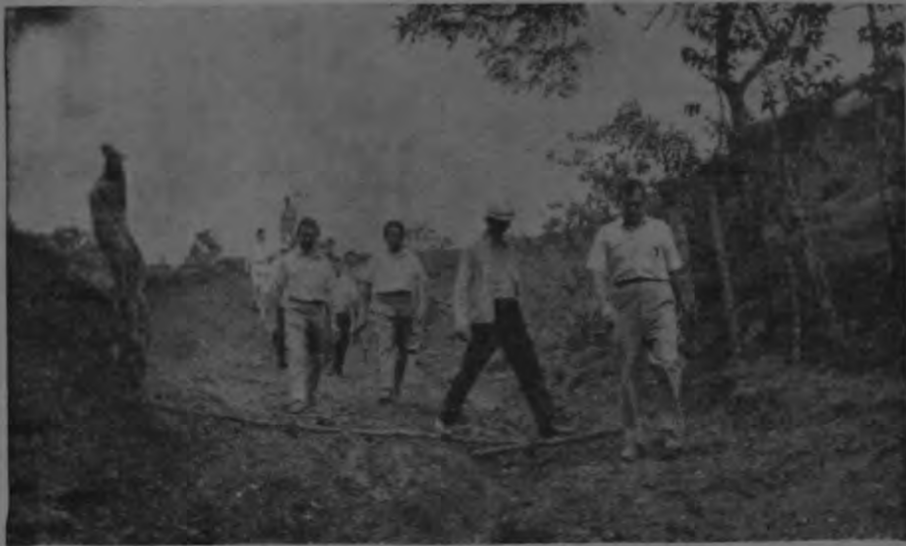
PURISCAL. — La fotografía fue tomada cuando el Ministro de Obras Públicas y Transportes, licenciado Carlos Manuel Coto Albán realizaba un recorrido por el Cantón de Puriscal, donde observó personalmente algunas necesidades via-
